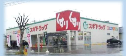
施工事例 スギ薬局 さま
