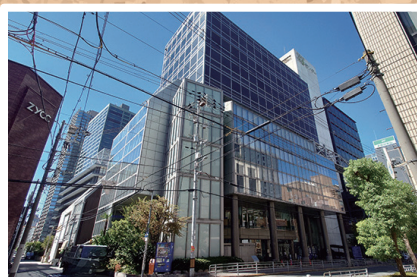
▲訓練施設の外観
