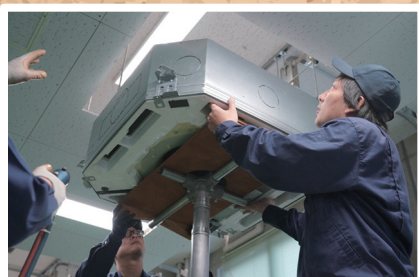
▲業務用エアコンの設置中です。
