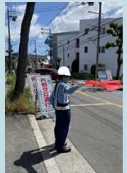
交通誘導警備
