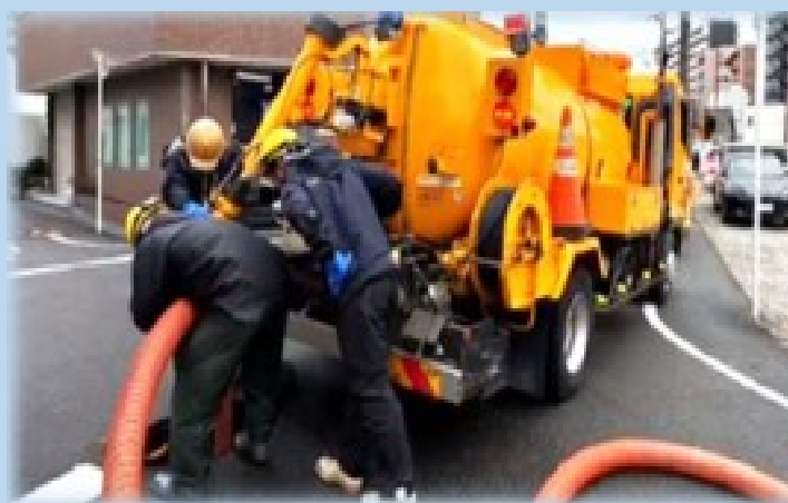
強力吸引車での吸い上げ
