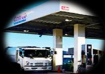
ガスステーション
