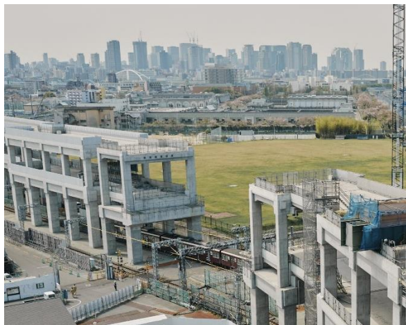
阪急淡路駅の橋梁工事
