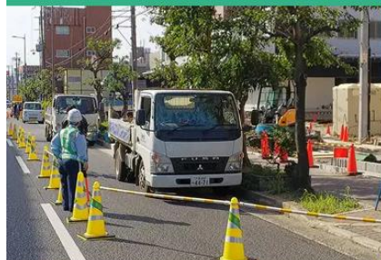
工事現場等での車や人の交通誘導を行っております。
