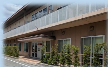
施設外観(ちのくらぶ2階)
