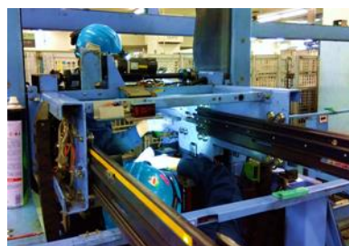
ケース移載機 点検風景
