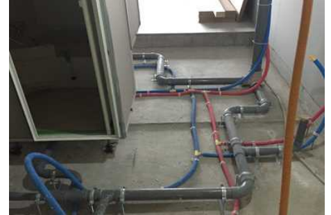
工事中の配管
