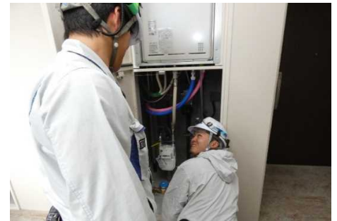
社用車で現場へ施工状況の確認！
