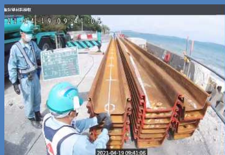
材料確認 現場
