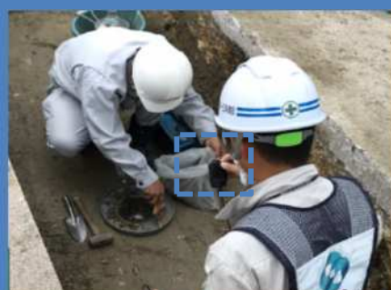
現場密度試験 現場
