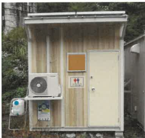
快適トイレ外観
