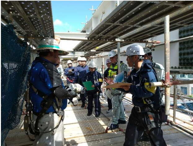
点検表にて吸収缶の交換状況を確認する様子
