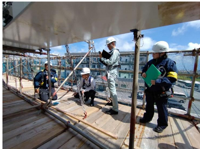
つり足場にて、墜落・転落防止措置と物体落下防止措置について説明を受けている様子
