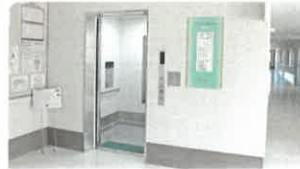
エレベーター
