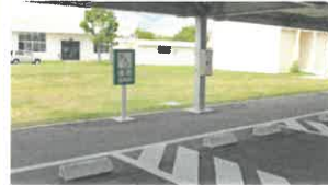
屋根付き駐車場
