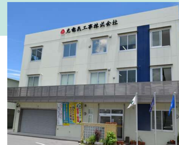
光電気工事外観
