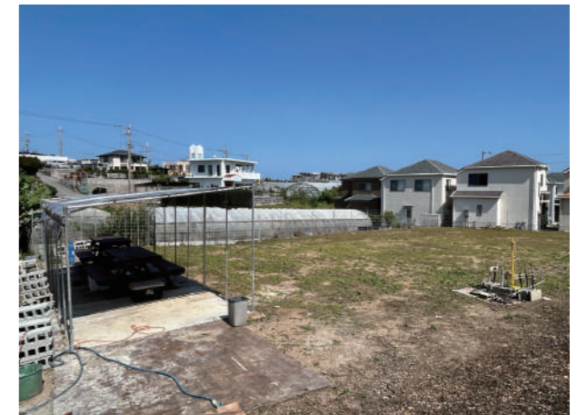
現在工事中の手作りの遊び場とバーベキュー場
