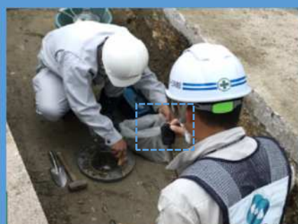
現場密度試験 現場
