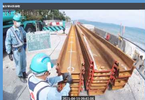
材料確認 現場
