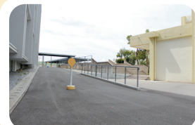
体育館前スロープ
