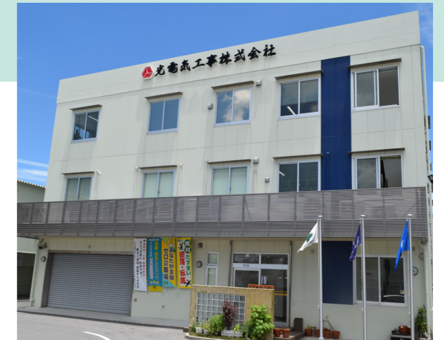
光電気工事外観
