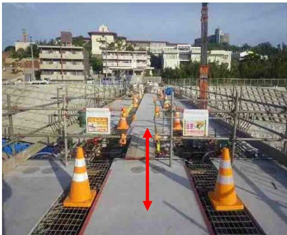
地覆工施工時（橋面外側を作業通路）
