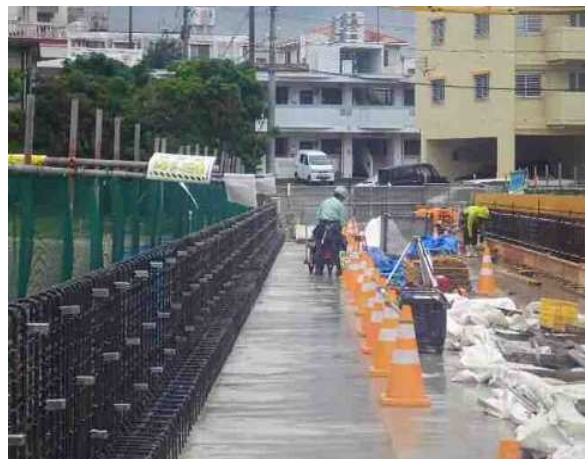
地覆工施工時（橋面外側を作業通路）
