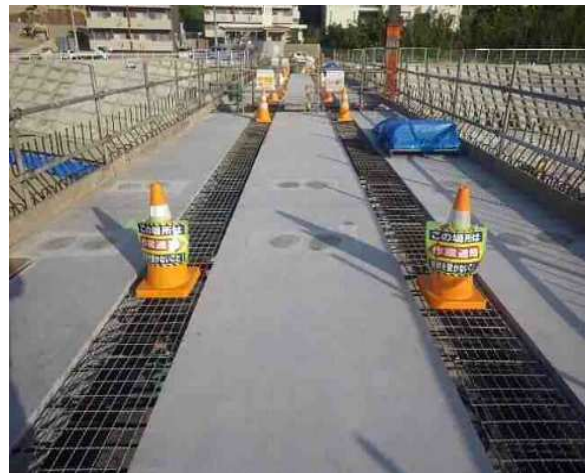
地覆工施工時（橋面外側を作業通路）
