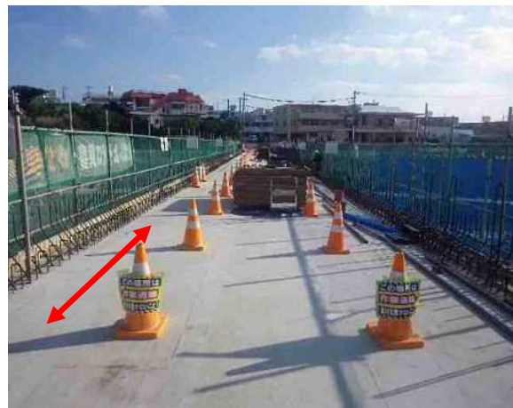
地覆工施工時（橋面外側を作業通路）
