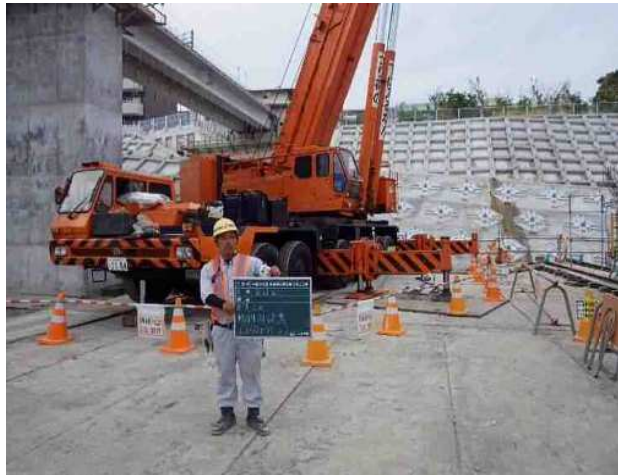
主桁架設用360tクレーン
