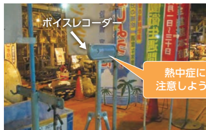
工事現場にボイスレコーダーを設置し愛の声掛け実施
