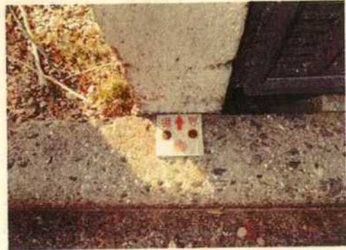
(3) 近景 金属プレート
