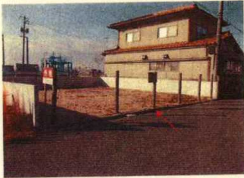
NO.13 (北面) L字溝
