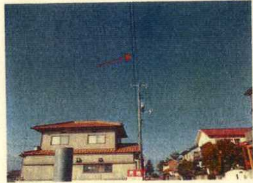
NO.14 (北面) 電線
