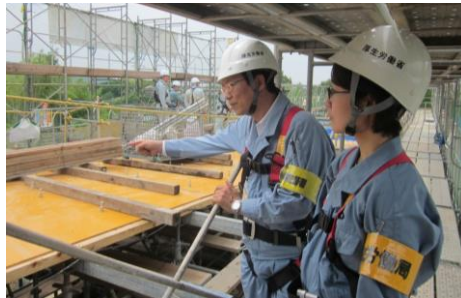
型枠の設置状況を確認する北村健康安全課長(右)と小松原副署長(左)
