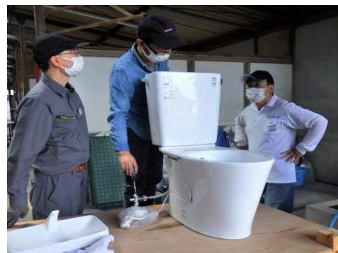
衛生器具設置
