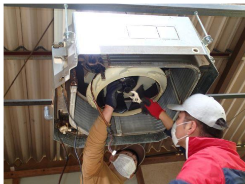
天井カセット型エアコン点検
