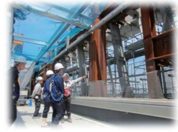
労働局長による建設現場パトロール
