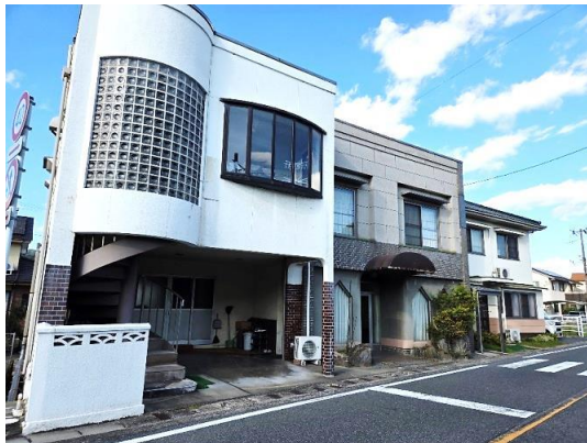
大きな2階建ての全体がグループホーム菩提樹の花
