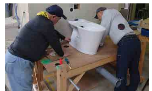
衛生器具設置
