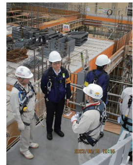
労働基準部長による建設現場パトロール
