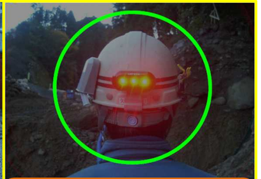
暗い場所、暗い時間帯にあっても、作業員の存在が認識できるように、ヘルメットにライトを装着している
