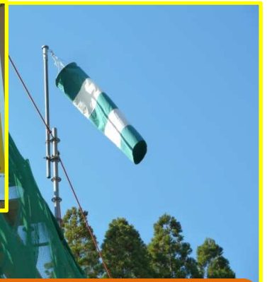
クレーン作業等がある現場で、風速が判別しやすいよう目安を掲示している
