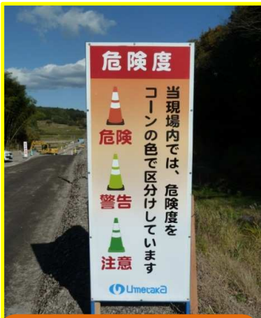
現場内の各区域の危険度をコーンの色で区別している
