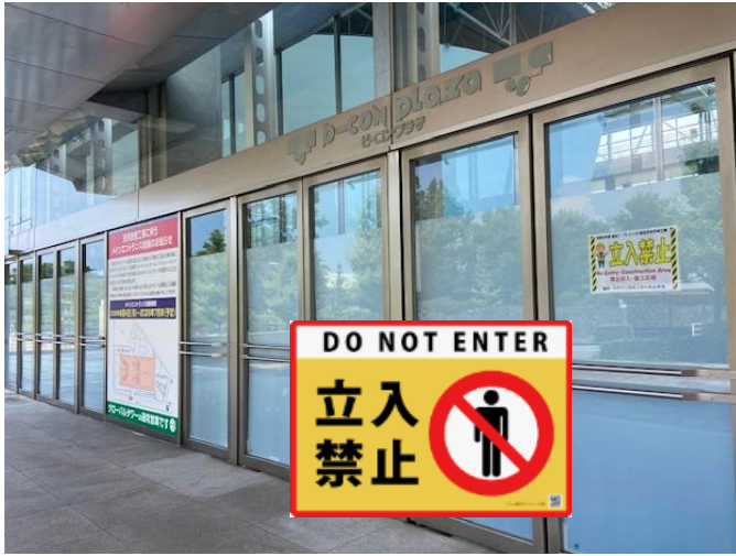
メインエントランス (正面玄関) 立入禁止
