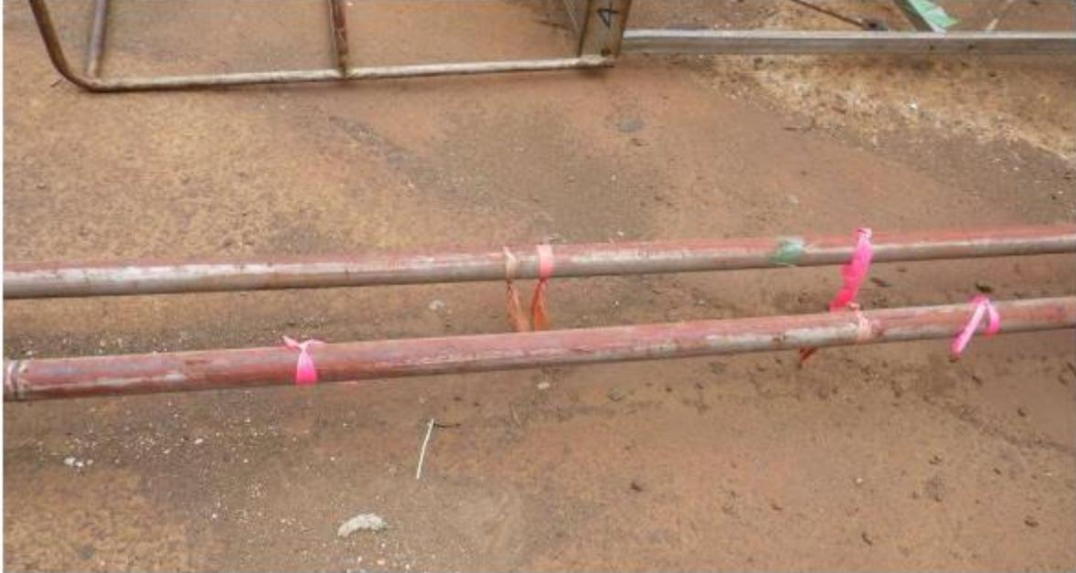
作業通路で躓き易い配管にピンクリボンを設置
