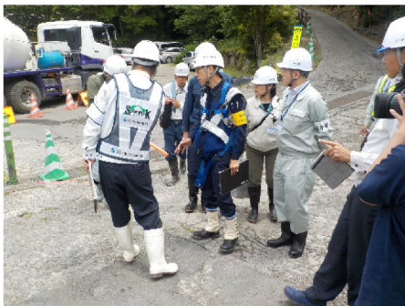
【現場でのパトロールの様子】
