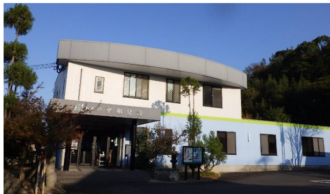
株式会社平和建設本社(大分県大分市)
