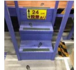
段差の高さを「見える化」
