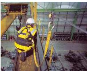
墜落制止用器具の使用例 ▶
