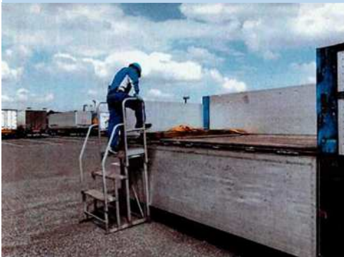
墜落・転落防止：昇降台の導入
