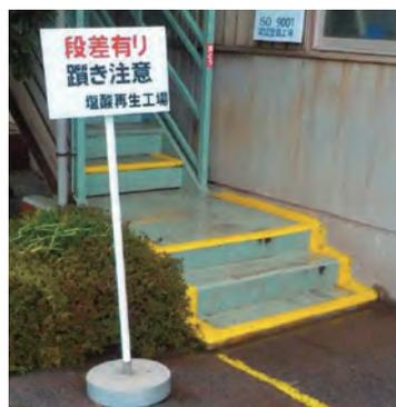
段差の高さが異なるなど転倒しやすい場所に段差注意の表示をして転倒災害を防止している。
