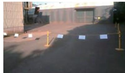
重機との接触災害防止のため、作業エリアをバリケードで囲い、重機稼働範囲を明示した。
