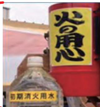
ガス切断作業等を行う高所作業車のバスケットに初期消火用ペットボトルの収納場所を設置。火花で穴が開いたり作業者が踏み付けたりすることがなくなった。
