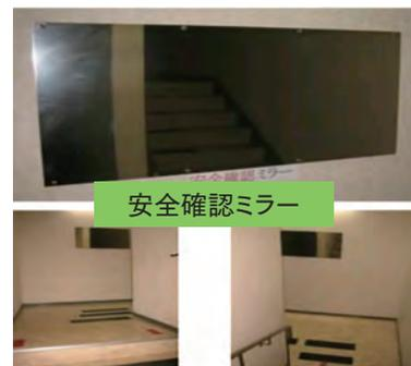
踊り場Uターン箇所の壁面に設置し進行方向の様子が見える様にしている。
