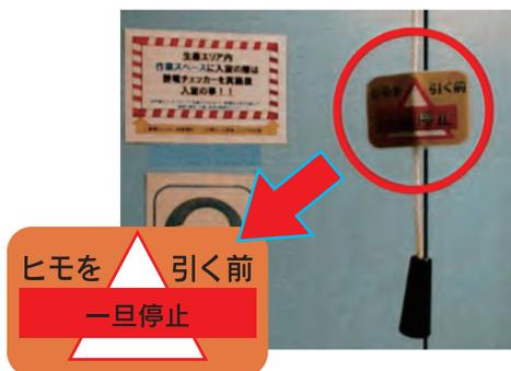
自動扉が開いた際の出会いがしらの衝突事故を防ぐため、自動扉の「開」用の吊り紐スイッチに一時停止用の注意喚起を表示している。
