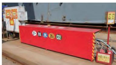
ガスヘッダーの場所と消火器の場所を表示。ガスヘッダーには上部から火の粉による火災防止のため屋根を設けている。
