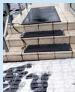
《ヒートマットの設置例》
