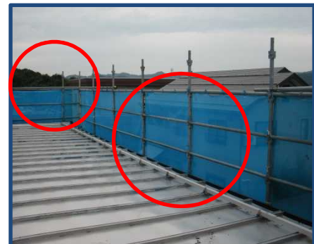
○ D邸新築工事(墜落防止、補強)
