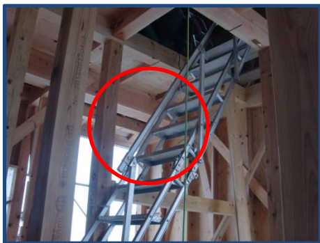
○ A邸新築工事(手すり付はしご使用)
