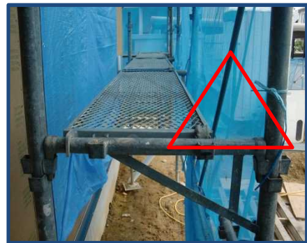
△ C邸新築工事(巾木等)
