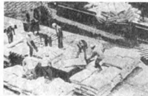
陸揚げされた石綿のパレットへの積み替え作業
