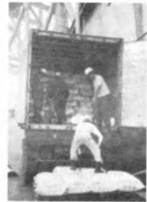
コンテナからの石綿のバン出し作業
