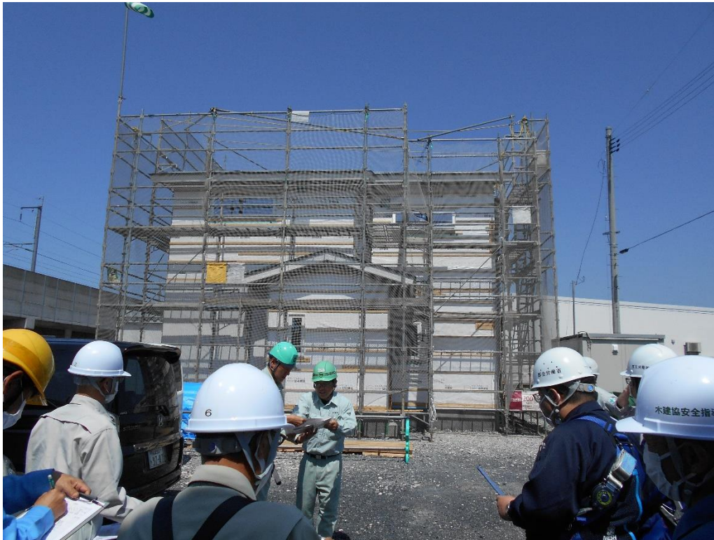
現場代理人より足場などの説明：（株）谷村建設の木建現場
