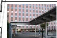
駐車場 雨除けの庇
