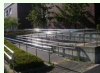
スロープ 誘導用点字ブロック
