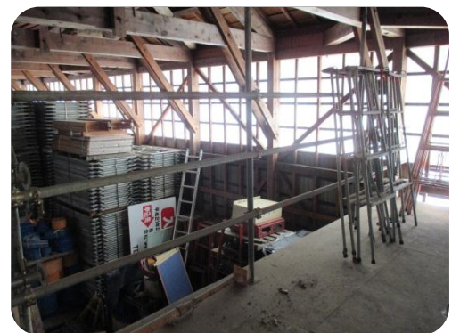
(手すり等を設置した例)
