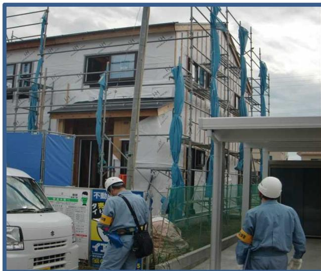
パトロールの結果、多くの現場で改善を要したのは、「物体の落下による危険防止措置が講じられていない」、「建地の間隔が1.85m以下となっていない」、「足場の点検結果を記録し、保存していない」でした。
