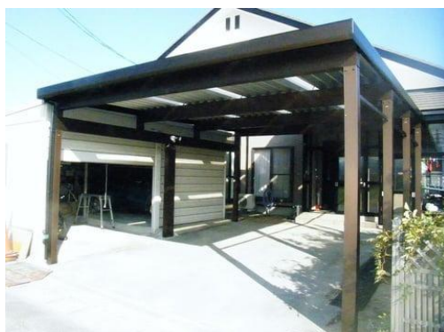
完成したカーポート
