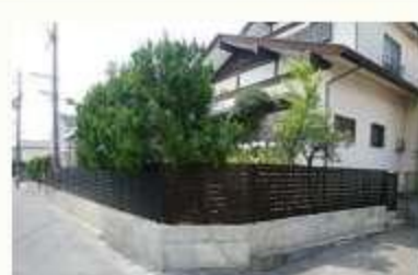
エクステリア工事
