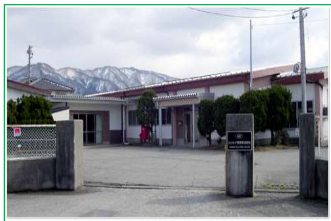
本社事務所・工場外観
