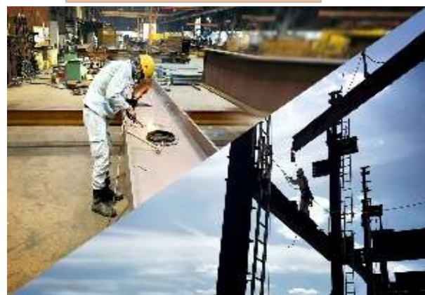
作業現場風景及び建設現場風景
