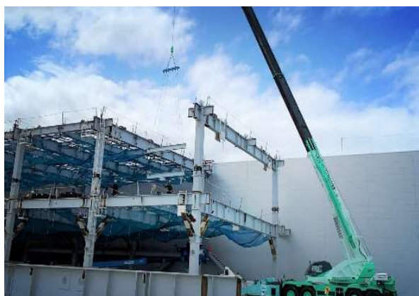
建設現場作業風景
