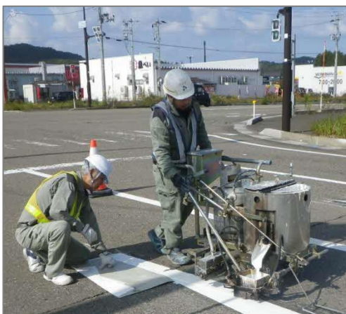
路面標示工事（矢印）
