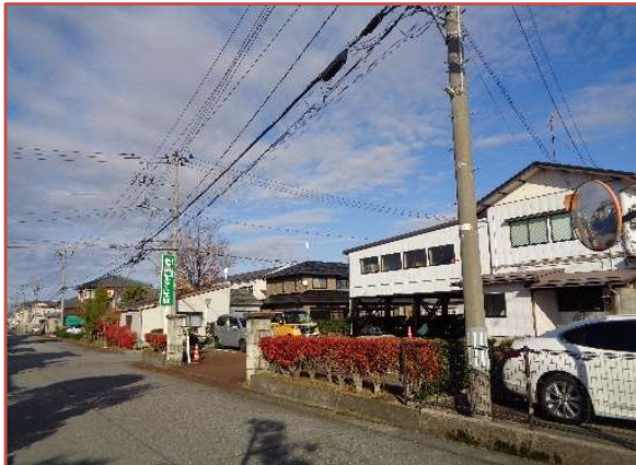
本社事務所外観風景
